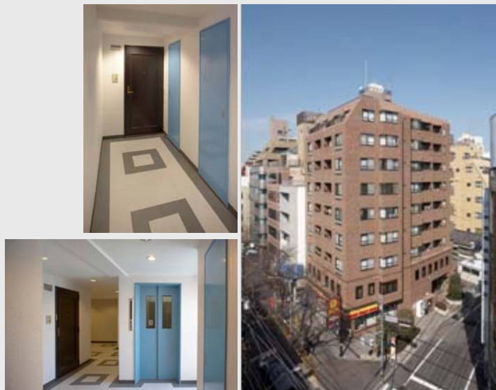
大規模修繕完了後
